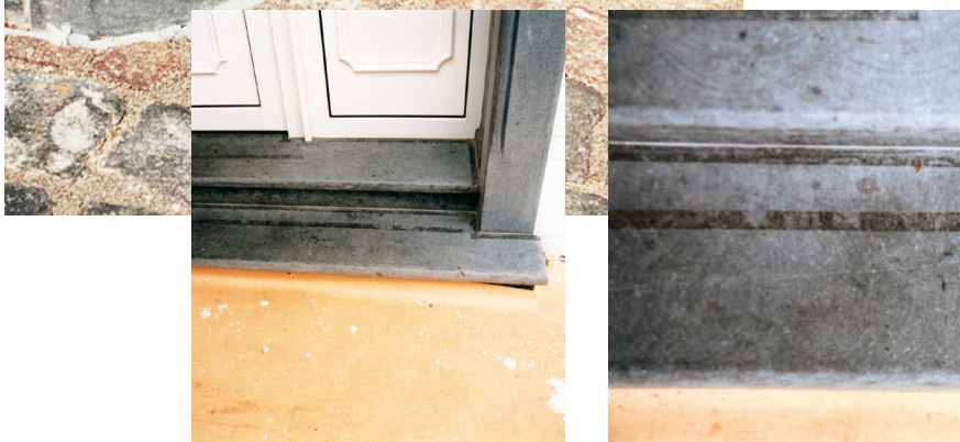
Färgförändringar på natursten (belgisk granit, matt finish) efter användning av tejp
