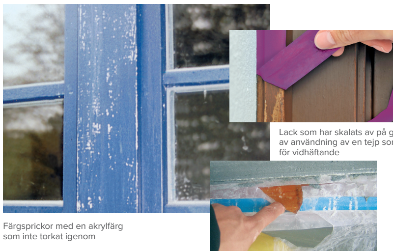
Skadat trä efter putsapplicering. Orsak: Maskering med folie som inte är tillräckligt stark
