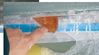
Skadat trä efter putsapplicering. Orsak: Maskering med folie som inte är tillräckligt stark
