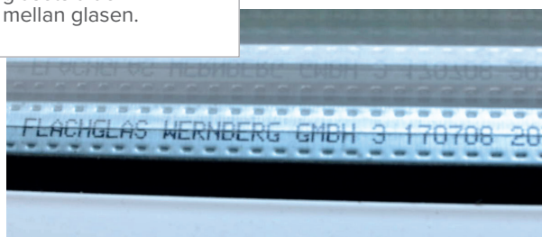
Information om tillverkningsår på glasrutans distanshållare (2008-07-17)
