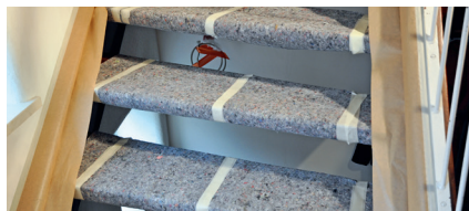
Öppna trappor: Använd endast tejp för att "linda" runt omslaget
