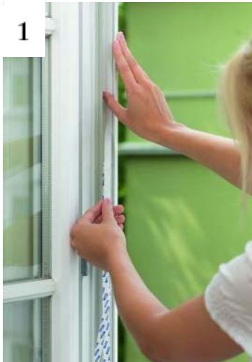
Nakleić rzep samoprzylepny do ramy okna
