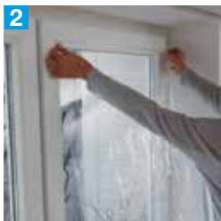
Zamocować osłonę termiczną
