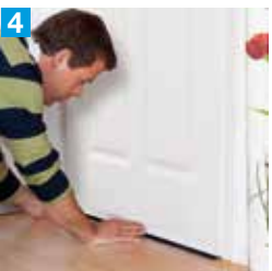
Docisnąć uszczelkę szczotkową do drzwi
