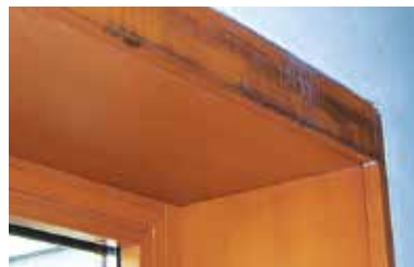
Hoewel de deur was afgeplakt, drong er water in het deurkozijn door, zodat dit niet kon uitdrogen
