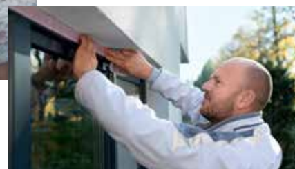
De dubbelzijdige zelfklevende tape tesa® 4836 maakt het eenvoudig om afzonderlijke maskering aan te brengen
