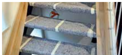
Open trap: Gebruik alleen zelfklevende tape om de afdekfolie 'vast te zetten'
