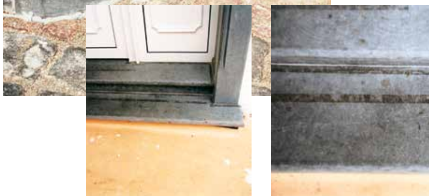
Kleurveranderingen van natuursteen (Belgisch graniet, matte afwerking) na gebruik van zelfklevende tape
