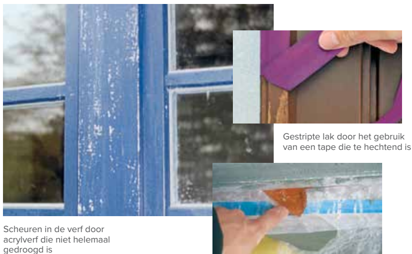
Beschadigd hout na aanbrengen van gips. Reden: Afgeplakt met onvoldoende sterke film
