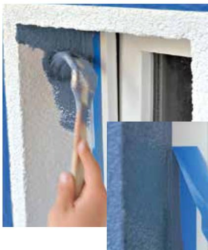
Lorsque vous travaillez à l'extérieur sur une façade, les fenêtres et les parties de la façade doivent être couvertes. L'adhésif doit souvent durer des jours et des semaines ; puis être retiré rapidement et sans laisser de résidus
