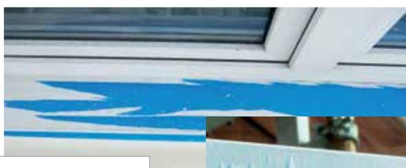
Ruban adhésif déchiré à plusieurs reprises en raison d'un pouvoir adhésif excessif sur le rebord de fenêtre en aluminium patiné
