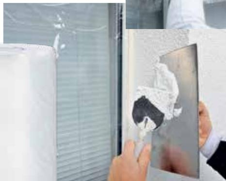
Protection fiable de la fenêtre avec le film de protection robuste tesa Easy Cover® 4373 UV Extra robuste. Il est trois fois plus épais que les films courants des solutions combinées ruban-film
