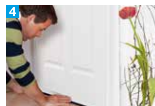
4 Press door brush onto the door
