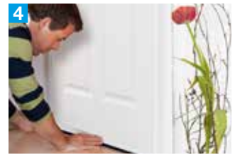
4 Press door brush onto the door
