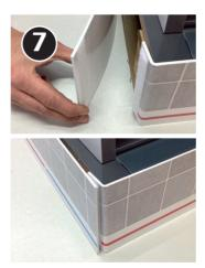
Coprire il pallet con i due pannelli dello zoccolo (1) fissandoli con il velcro.
