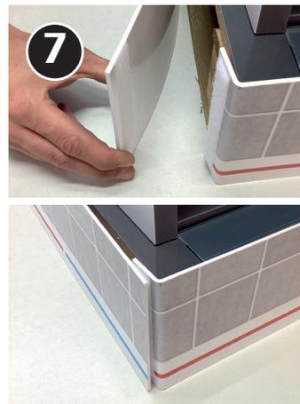
Couvrir la palette avec les deux panneaux de plinthe (H) en les collant ensemble.
