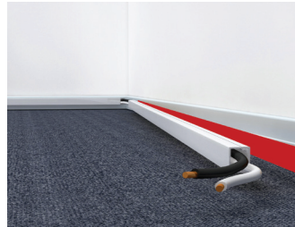
Συναρμολόγηση καναλιών καλωδίων
