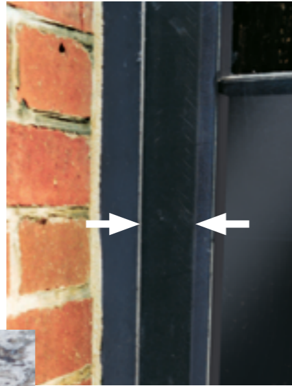
Dunkle Bandspur auf verwittertem Eloxal, keine Klebemasserückstände
