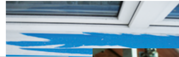
Immer wieder eingerissenes Klebeband aufgrund zu hoher Klebkraft auf verwitterter Alu-Fensterbank
