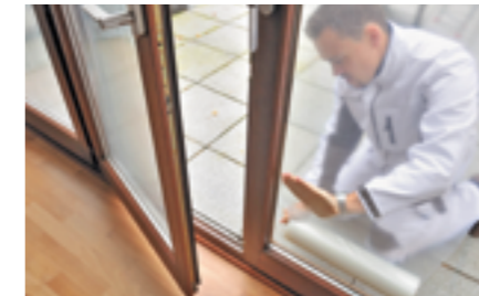
Tageslicht und Lüftung: Abdecken mit tesa® 4848 Oberflächenschutzfolie
