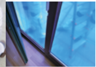
Kein Tageslicht, keine Lüftung: vollflächige farbige Folienabdeckung
