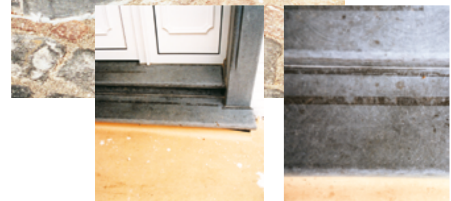
Farbveränderungen auf Naturstein (belgischer Granit, matt geschliffen) nach Klebebandeinsatz
