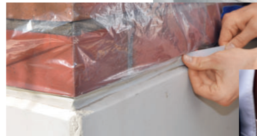
Verkleben auf Silikonichtungen: nur mit Spezialmaterial möglich, z. B. tesakrepp® 4331
