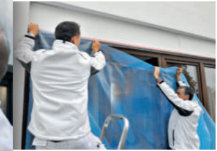
Das Verkleben einer herkömmlichen Abdeckfolie dauert deutlich länger und ist wesentlich aufwändiger
