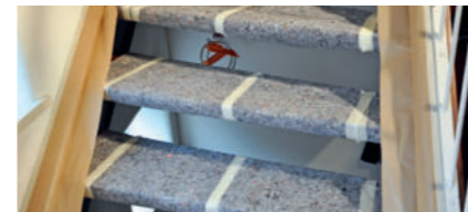
Offene Treppenstufen: Klebebänder nur zum „Umreifen“ der Abdeckung einsetzen
