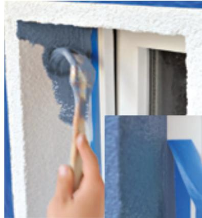
Bei Außenarbeiten an der Fassade müssen Fenster und auch Fassadenteile abgedeckt werden. Der Verklebung muss oft Tage und Wochen halten – und sich dann schnell und ohne Rückstände wieder entfernen lassen
