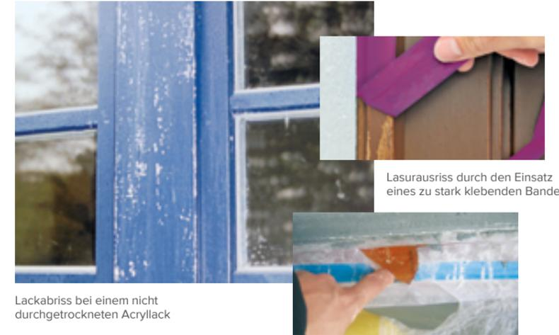
Lackabrisse bei einem nicht durchgetrockneten Acryllack
