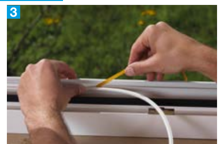
3 Dichtungsstreifen kräftig im Rahmen andrücken
