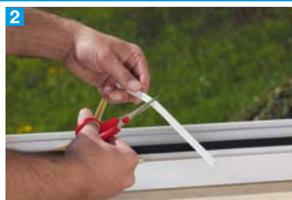
2 Dichtung auf die richtige Länge zuschneiden
