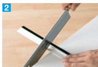
2 Türdichtschiene auf Maß zusägen
