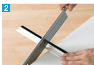
2 Türdichtschiene auf Maß zusägen
