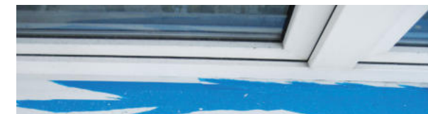
Immer wieder eingeklemmtes Klebeband aufgrund zu hoher Klebkraft auf verwitterter Alu-Fensterbank
