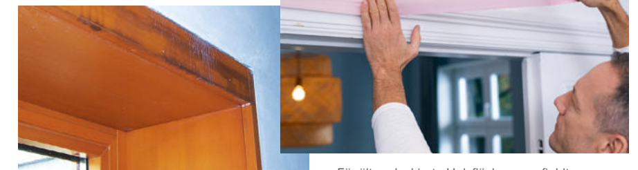
Trotz Abklebung gelangte Wasser an den Türrahmen und konnte nicht abtrocknen
