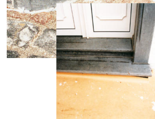
Farbveränderungen auf Naturstein (belgischer Granit, matt geschliffen) nach Klebebandeinsatz
