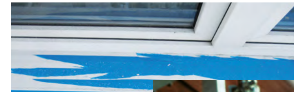
Immer wieder eingeklebrtes Klebeband aufgrund zu hoher Klebkraft auf verwitterter Alu-Fensterbank
