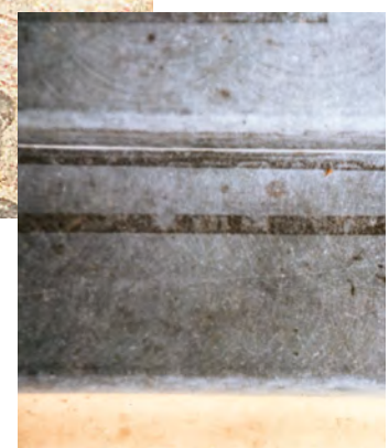
Farbveränderungen auf Naturstein (belgischer Granit, matt geschliffen) nach Klebebandeinsatz
