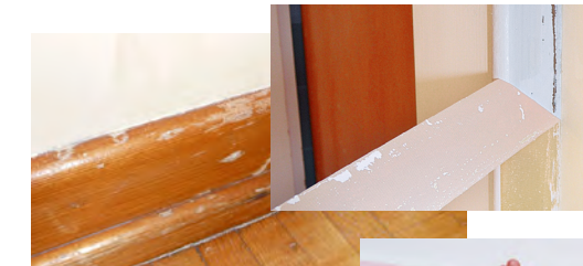
Schäden bei älteren Lasuren/Lacken durch zu starke Klebkraft
