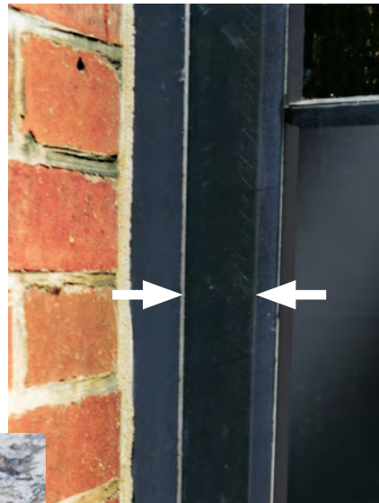
Dunkle Bandspur auf verwittertem Eloxal, keine Klebemasserückstände
