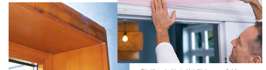
Trotz Abklebung gelangte Wasser an den Türrahmen und konnte nicht abtrocknen
